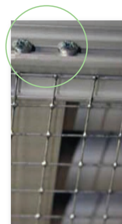
Fixation par vis du raidisseur
